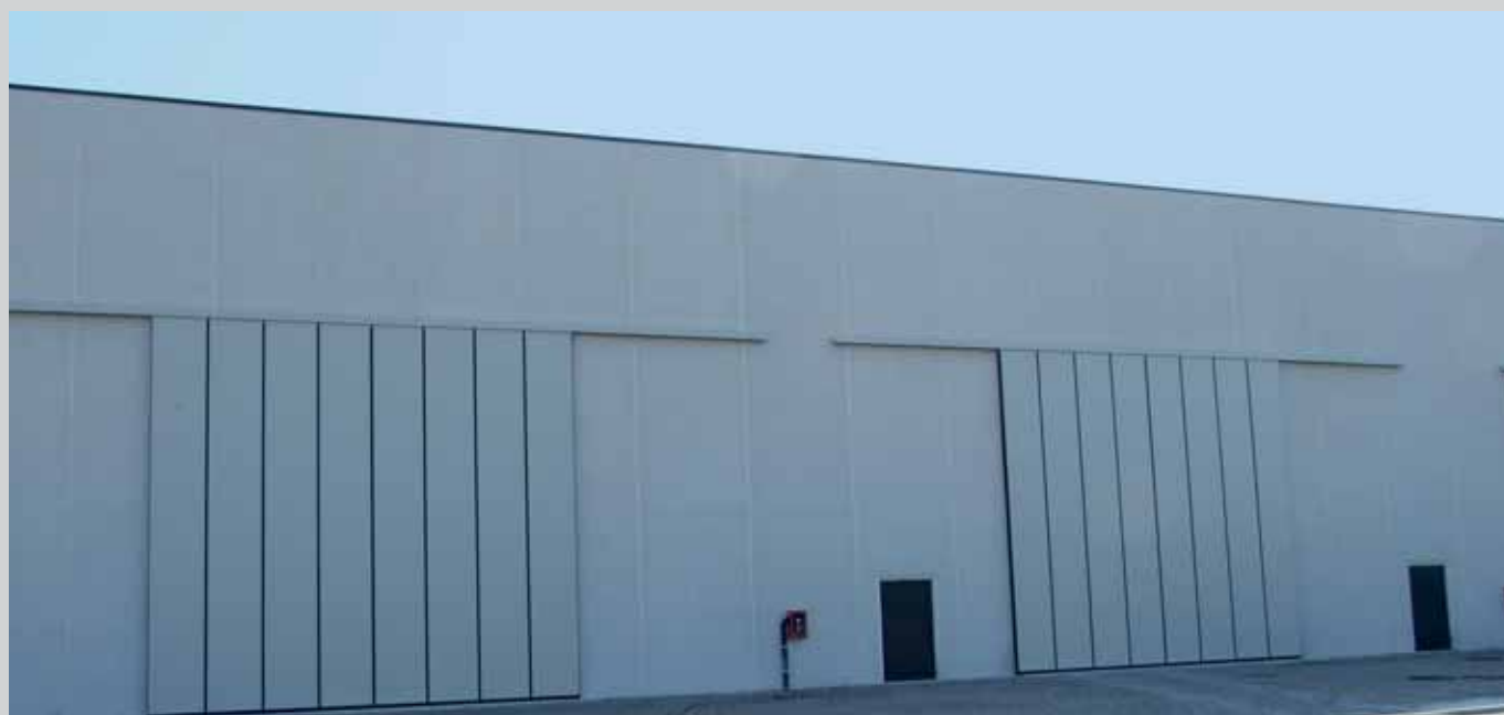
Portone scorrevole serie SN doppia anta applicato all'esterno e dotato di carter copri guida superiore.
