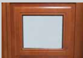
Vista esterna Vue extérieure
