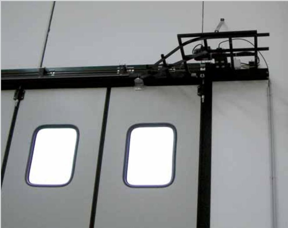
Dettaglio guida superiore versione LG predisposta alla motorizzazione.
