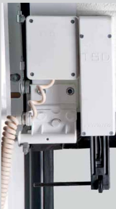
Nuova ed esclusiva fotocellula di sicurezza. Viene installata nella parte interna della porta sezionale, in grado di arrestare ed invertire la corsa della porta PRIMA DELL'IMPATTO CON L'OSTACOLO.
