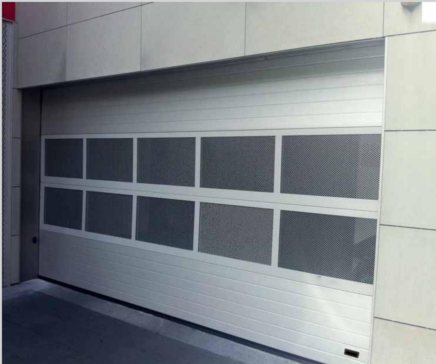
Esempio di realizzazione porta sezionale con inserti in alluminio tamponati con rete stirata. Possibilità di utilizzo su tutte le estetiche e modelli.
